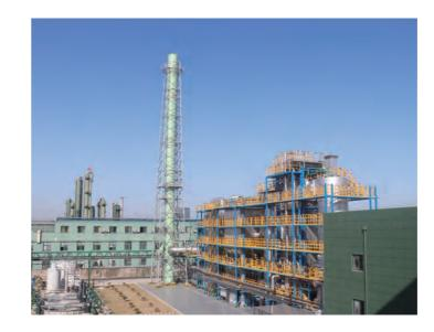
巨联位于江苏吴江的危废焚烧基地,设计处理规模为 10000 吨/年,能够处理国家危险废弃物目录上 12 大类的不同工业废弃物,并提供包装、转运、运输、分析等服务。焚烧过程中产生的蒸汽回用于有机废液利用中心,实现资源的循环利用。
